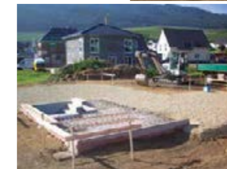
Die Errichtung eines Fertiggellers auf der Baustelle geht dank des hohen Vorfertigungsgrades schnell vonstatten – in der Regel innerhalb von maximal drei bis fünf Tagen. Glatthaar Fertiggeller
