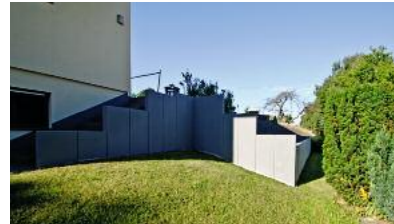
Großflächige Stützwände sichern den Hang und schaffen angenehm nutzbare Rasenflächen rund ums Haus.
