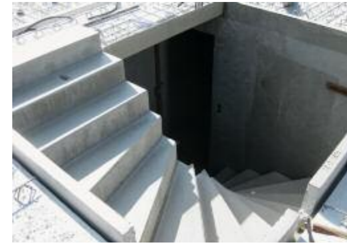
Innerhalb kürzester Zeit war auch dieser anspruchsvolle Fertiggeller in Hanglage aufgebaut und wohnfertig.
