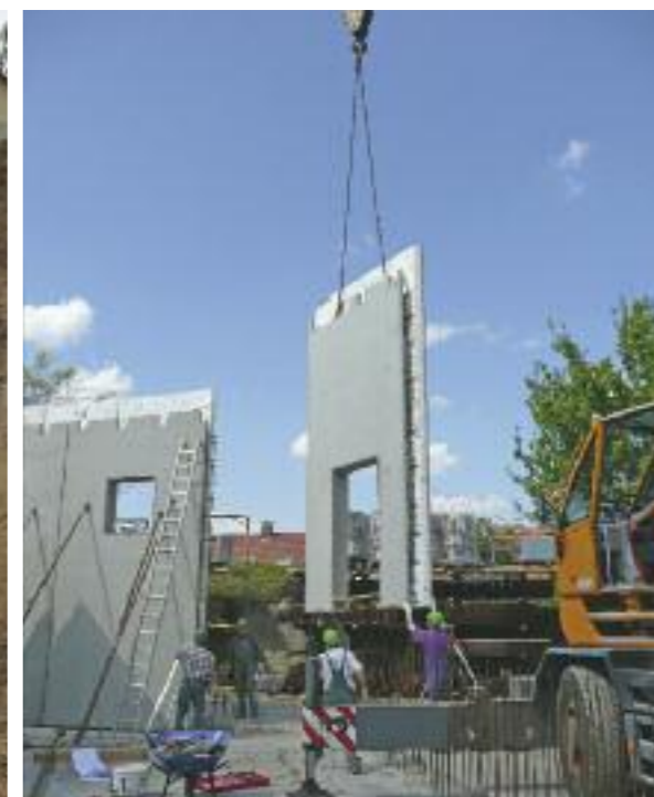
Bei der kerngedämmten Fertigteilwand werden Bewehrungsstäbe aus glasfaserverstärktem Kunststoff eingesetzt. Diese zeichnen sich durch eine sehr geringe Wärmeleitfähigkeit aus. Knecht
