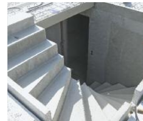
Der „ThermoSafe®“-Fertiggeller mit 24 Zentimeter Wandstärke plus 10 Zentimeter Dämmung dichtet gegen aufstauendes Sickerwasser ab und lässt das Haus rundum trocken sein. Glatthaar
