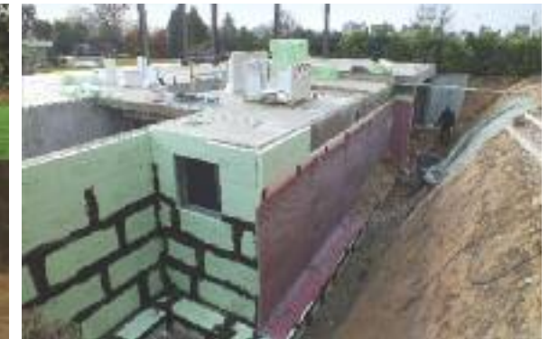
Meist wird zuerst eine Bitumengrundierung aufgetragen. Dann werden mit der Dickbeschichtung als Kleber die Dämmplatten aufgebracht. Glatthaar Fertigg Keller
