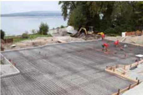
9. Einschalen und Verlegen der Bewehrung
