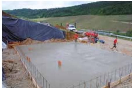
10. Betonage der Bodenplatte
