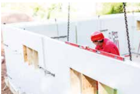
11. Versetzen der Kelleraußenwände
