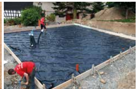
8. Einbringung der PE-Folie als Trennlage unterhalb der Bodenplatte
