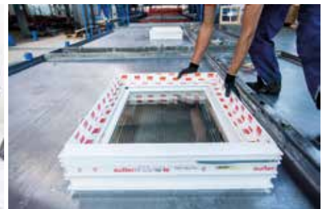
3. Einlegen der Einbauteile (Fenster, usw.) auf dem Schalungstisch
