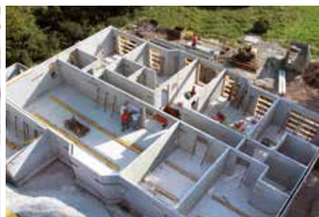
12. Versetzen der Kellerinnenwände
