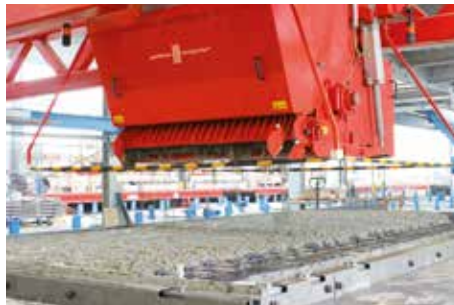
5. Automatisches Betonieren der jeweiligen Elementwandschale
