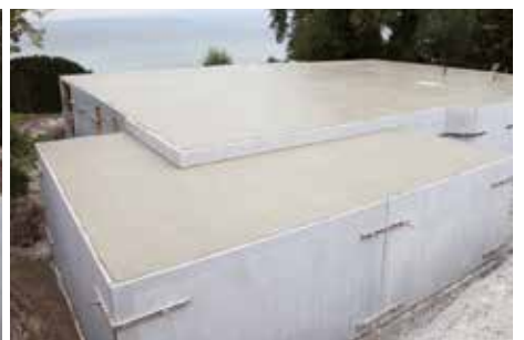
16. Fertig! Der frisch betonierte Glatthaar-Fertigkeller
