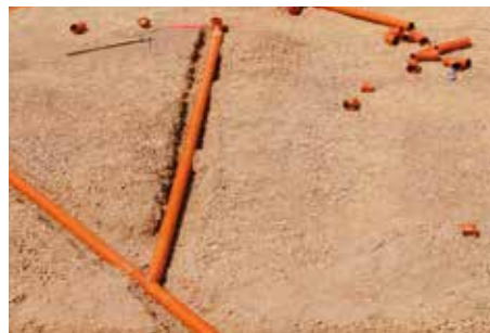
7. Verlegen der Entwässerungsleitung
