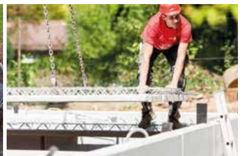
13. Verlegen der Filigrandecke
