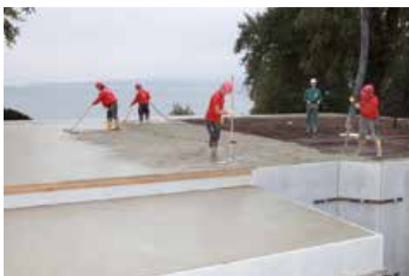
15. Betonage der Kelleraußenwände und -decke
