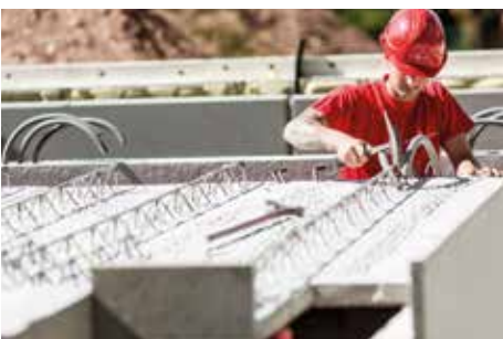
14. Verlegen der oberen Deckenbewehrung
