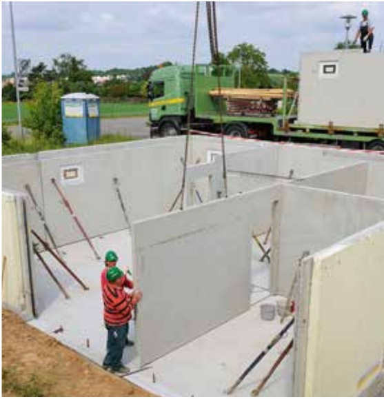
Der Kellerbau mit Fertigteilen ermöglicht auch größere Spannweiten ohne Stützen. Je nachdem, wie der Keller genutzt wird, können solche Optionen wichtig sein. Knecht Kellerbau
