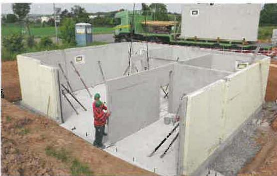
Der Kellerbau mit Fertigteilen ermöglicht auch größere Spannweite ohne Stützen.
